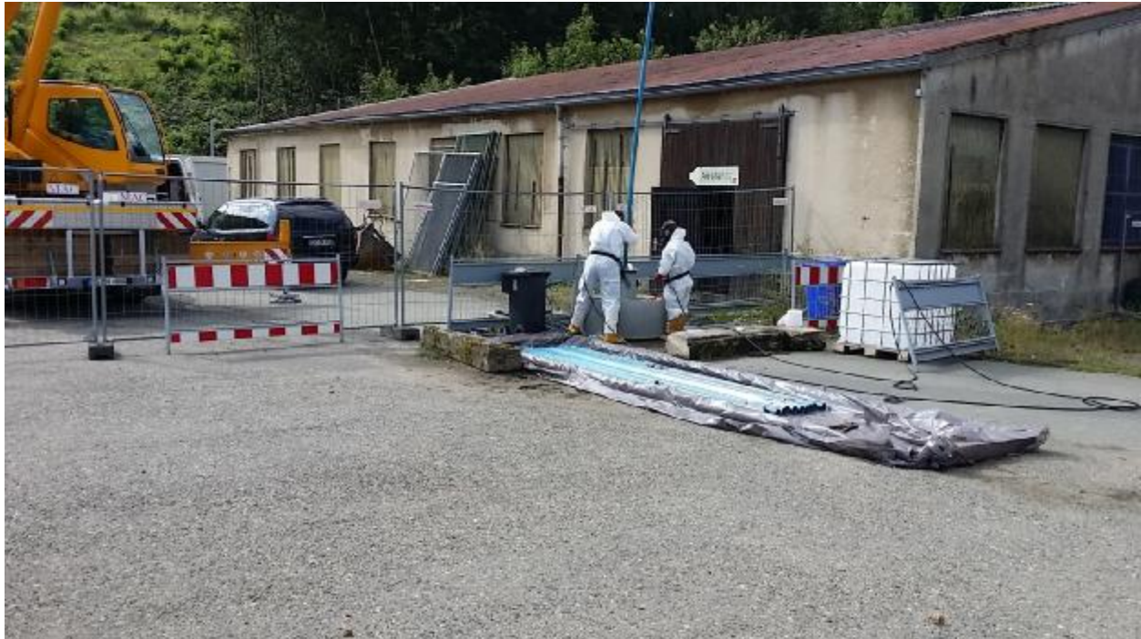
Abbildung 2 Pumpenausbau SP 8 unter erhöhten AS-Bedingungen
